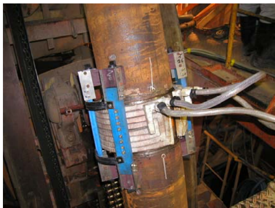
写真1. SMA継手による曲線鋼管の接続 5)
