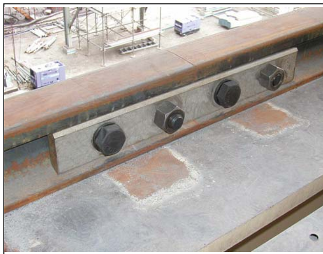
写真 2. クレーンレール用の SMA 製継目板
